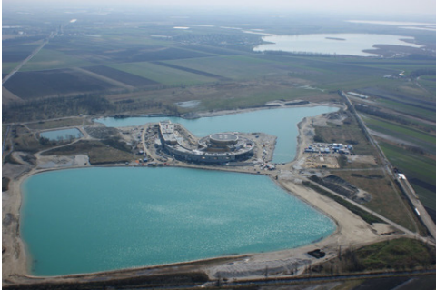
Baustelle St. Martins Therme und Lodge
