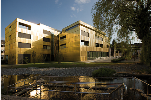
Außenansicht Hotel am See in Hard.
