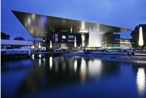
KKL Luzern Aussenansicht
