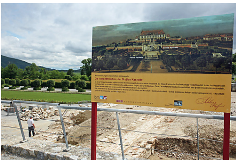
Grabungsarbeiten an der Großen Kaskade im Barockgarten von Schloss Hof
