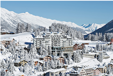
ENGADIN ST. MORITZ - In 2007 komplett renoviert empfängt das 1913 errichtete Carlton Hotel St. Moritz seine Gäste mit 60 Junior Suiten und Suiten - alle mit Blick auf den St. Moritzersee und die Engadiner Bergwelt.
