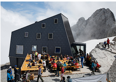
Seethaler Hütte (2.740 m), am Dachstein (OÖ)
